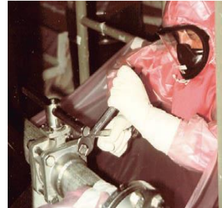
Formation PR1 CC INSTN Chantier école de Cherbourg-en-Cotentin © O. Crespin/CEA-INSTN
