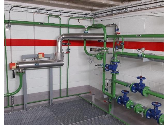
Chantier école CSQ de Cherbourg-en-Cotentin © A. Lebled/CEA-INSTN
