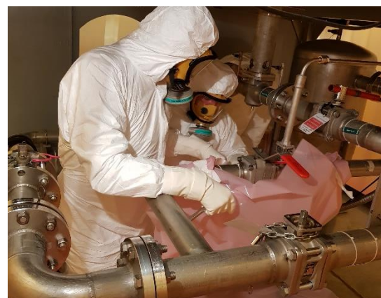
Formation PR1 RNE INSTN Chantier école Cherbourg-en-Cotentin © A. Lebled/CEA-INSTN
