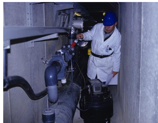
Mise en place préleveur automatique Copyright libre de droit ANDRA
