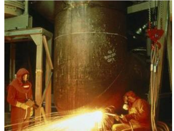
Démantèlement d'un échangeur de G2 © CEA
