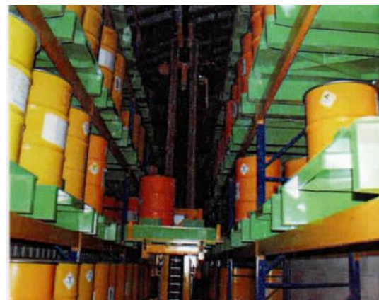
CEA/ entreposage des fûts de déchets à l'INB 72
